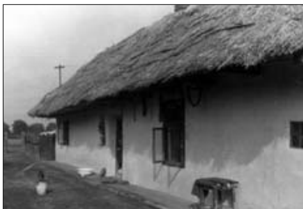
A Dózsa Gy. út 55. sz. alatti lakóház udvari homlokzata. Épült a XIX. század közepén
